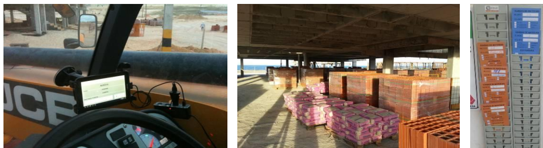
Figura 5 - Tablet na manipuladora, pavimento com set-up e kanban
